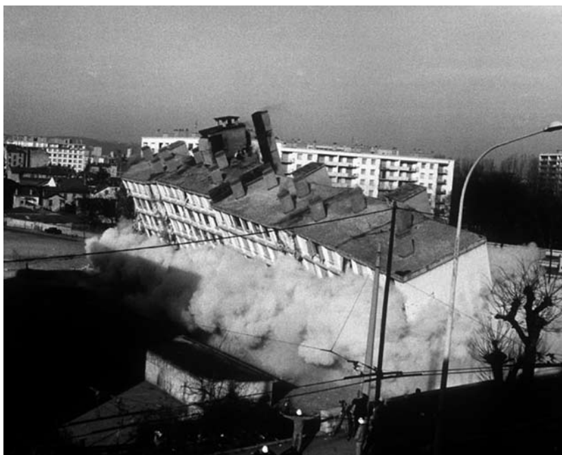
Vue du dynamitage d'une barre de la cité Olivier-de-Serres, 1982
