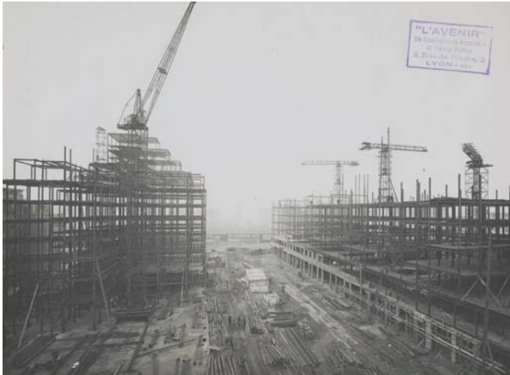
Plaque de verre E. Poix, pour l'entreprise « L'Avenir », Société coopérative de maçonnerie et travaux publics. Archives municipales de Villeurbanne
