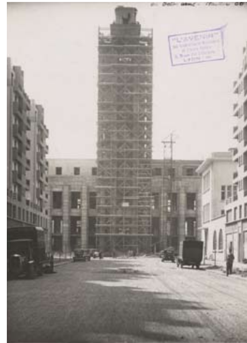
Plaque de verre E. Poix, pour l'entreprise « L'Avenir », Société coopérative de maçonnerie et travaux publics. Archives municipales de Villeurbanne
