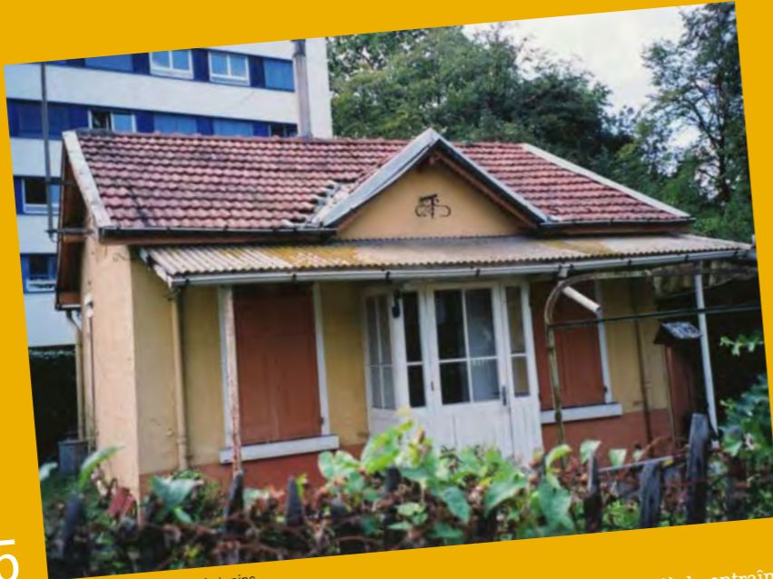
Maison Rolland, rue des Antonins
