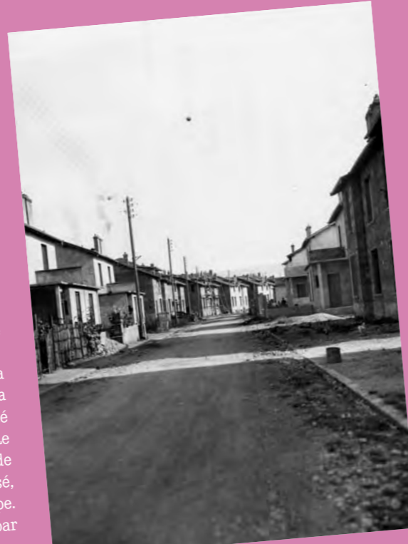
Cottages, rue Blasco-Ibanez, 1932-1934
