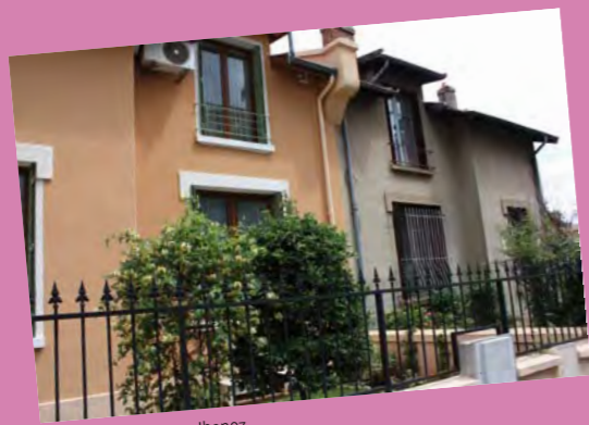
Cottages, rue Blasco-Ibanez
